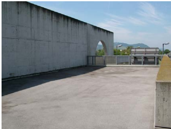
Abb. 137: Restfläche vor der Volksschule Donau City
