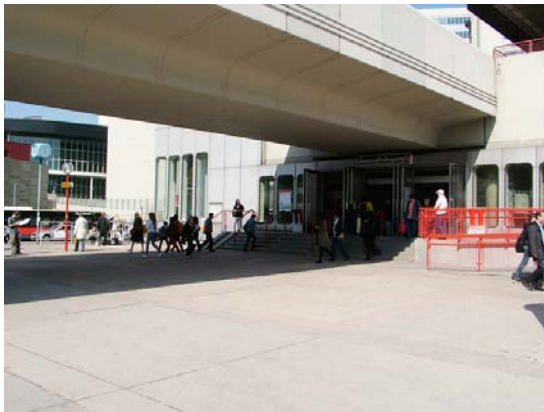
Abb. 121: U-Bahn Station Kaisermühlen – VIC
