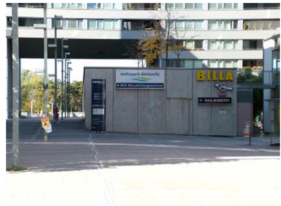
Abb. 140: eingeschossiges Infrastrukturgebäude im Wohnpark Donau City
