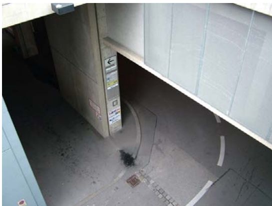
Abb. 139: Bodenöffnung bei Strabag Haus
