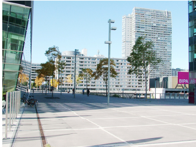
Abb. 200: kleine, stark durchlässige Baumkronen erwirken keine Verbesserung der Windsituation
