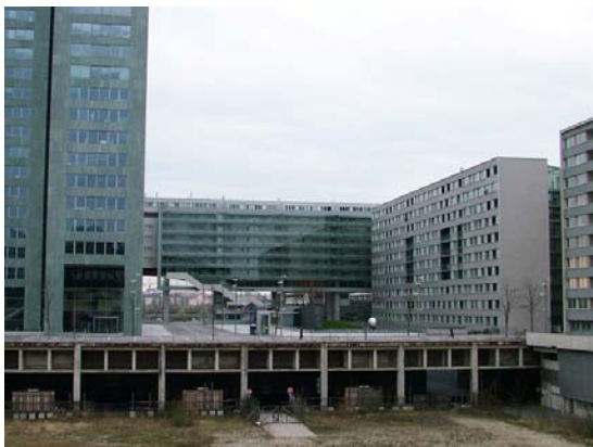
Abb. 144: Ares Tower Vorplatz
