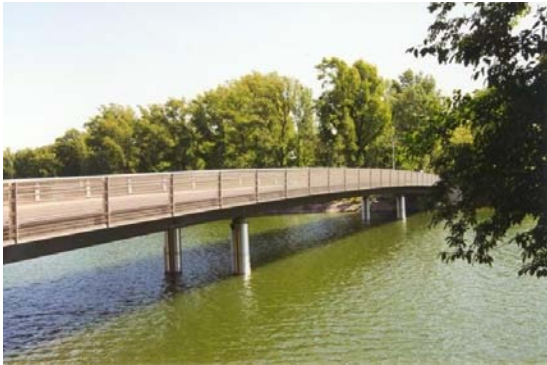
Abb. 79: Brücke auf die Binneninsel Gänsehäufel
