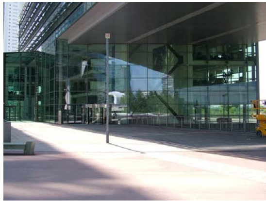
Abb. 138: Gebäuderücksprung am Tech Gate
